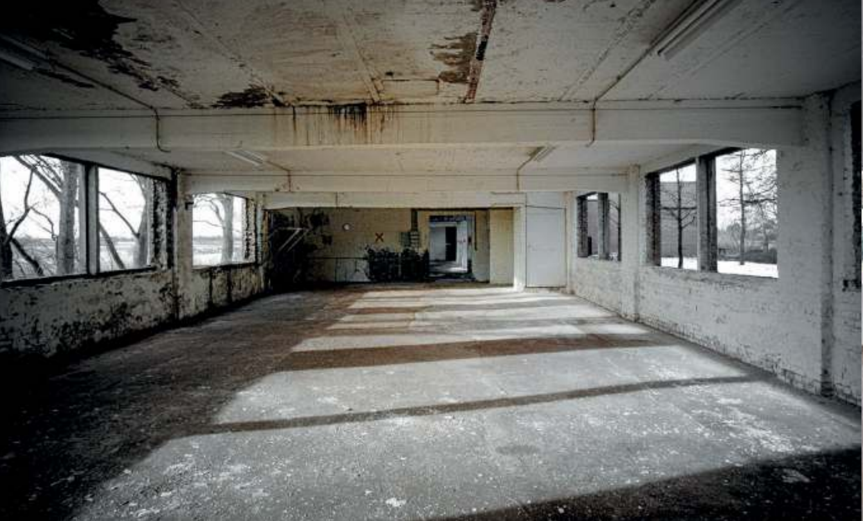
Een beeld van de loft voor de transformatie. De extra steunen zijn er later bijgekomen.
